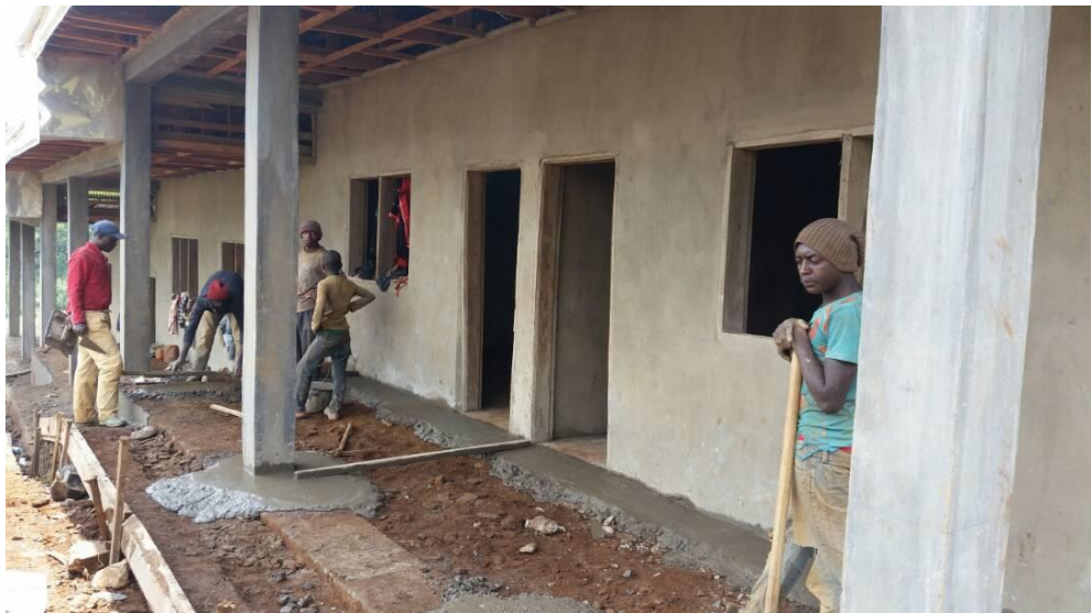
Zementarbeiten vor den überdachten Eingängen zu den Klassenräumen, © Force-Cam
