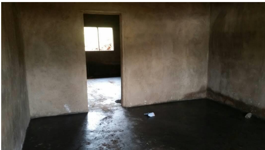
Zementierung der Fußböden in den Klassenzimmern, © Force-Cam
