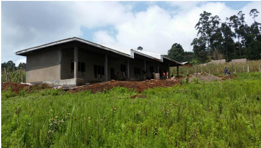
Ein Schulgebäude der King David Nursery and Primary School mit Außenputz, © Force-Cam
